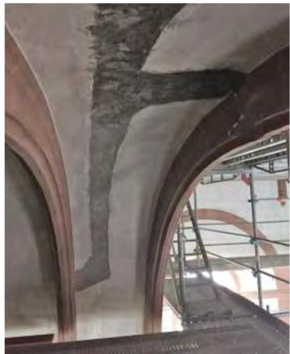
*Wieder geschlossen und verputzt. Die Bohrungen, in denen der Spann Stahl den fehlenden Ringanker ersetzt.*
